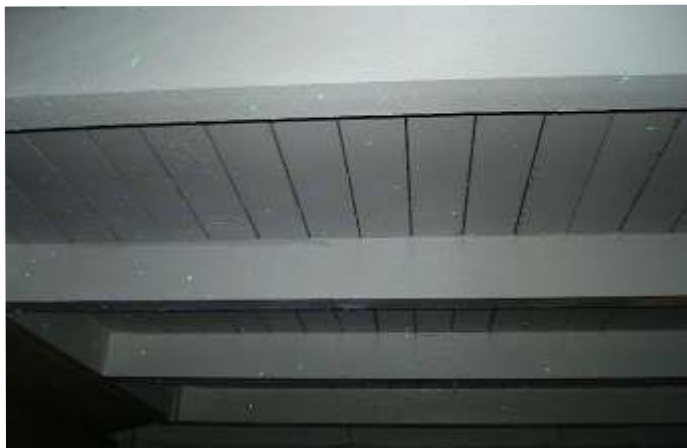
vorher : weiße Holzdecke mit Balken
