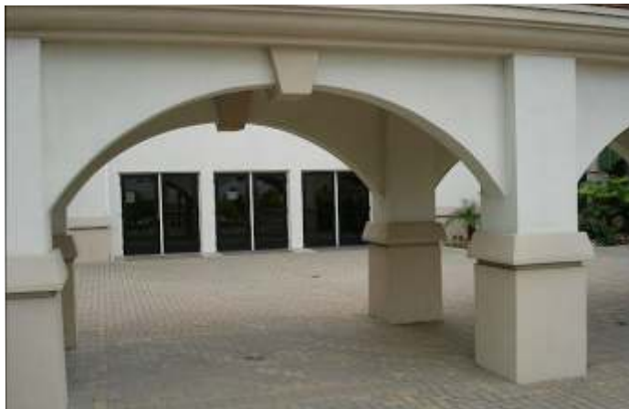
vorher : kaltes Betonbauwerk
